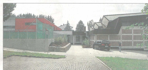
Gut zu erkennen: Die neue Kreissporthalle links ist mit der alten baulich verbunden. Der Neubau nutzt außerdem Teile der bestehenden technischen Infrastruktur der Bestandshalle wie Heiz- und Brandmeldeanlage sowie Notstromzentrale. Das muss an die heutigen Vorschriften angepasst werden.
