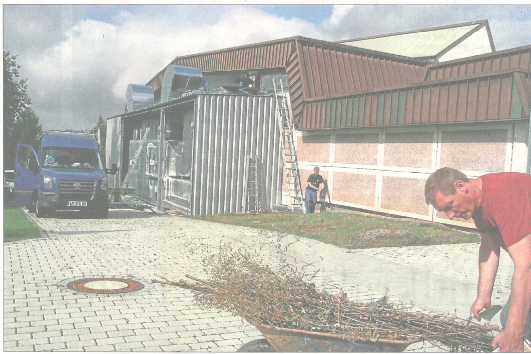
Hier wird gearbeitet: In der silberfarbenen Einhausung, ein Anbau an die alte Kreissporthalle, ist die neue Belüftung untergebracht.
