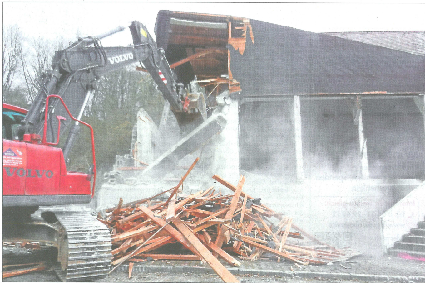
Mit dem Abriss der Münsterer alten Mehrzweckhalle ist jetzt begonnen worden.
