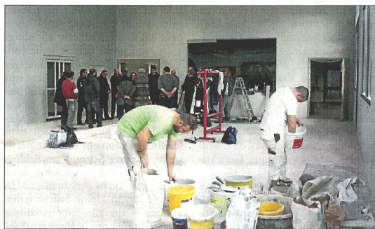
Bei einer Baustellenbesichtigung sahen sich Mandatsträger und Münsterer Bürger den neuen großen Saal der Halle an.
