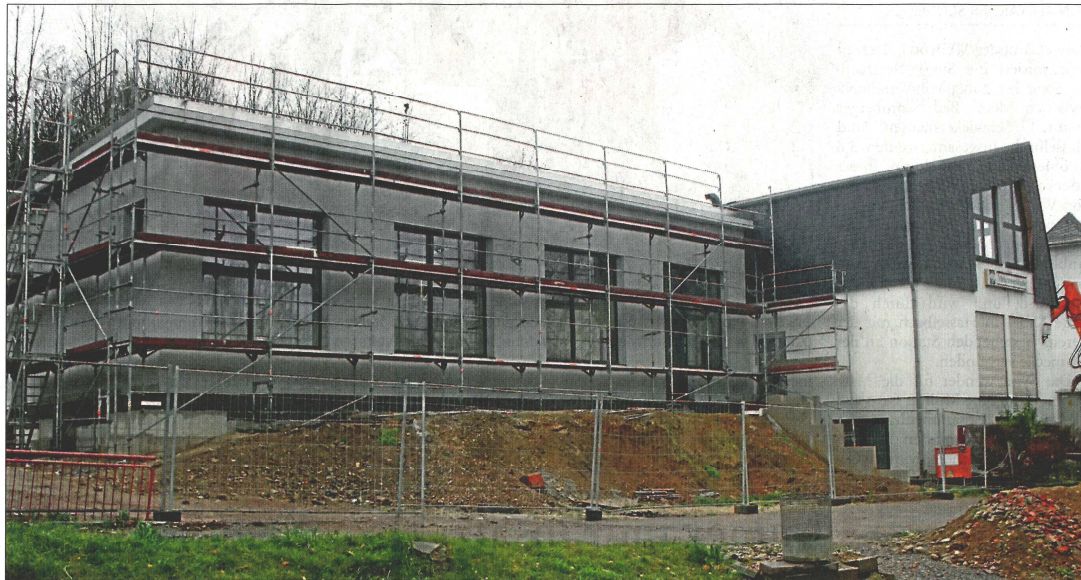
Der Neubau des großen Saales der Münsterer Mehrzweckhalle (links) steht bereits. Er wurde direkt an den Anbau des abgerissenen Altbaus (rechts) gesetzt. Fotos: Klöppel
