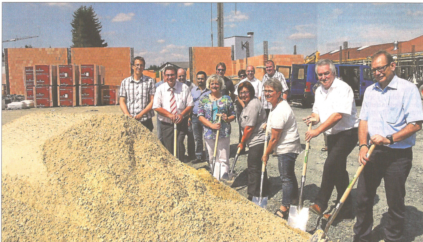
Erster Spatenstich vor dem bereits entstehenden Marktgebäude: (v. li.) Stefan Hopermann (Firma Weil), Architekt Willi Hamm, Bauherrin Elke Knie, REWE-Standortentwicklerin Gisela Benner, Cornelia Peter-Beeck, Bürgermeister Arnold-Richard Lenz und Hans-Peter Opel (Firma Opel, Diez). Foto: Goeckel
